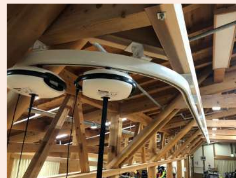
天井走行式リフト設置
