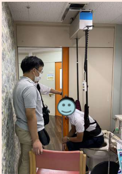
排泄用リフト設置
