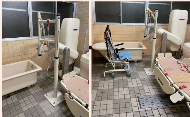
浴室にリフト設置
